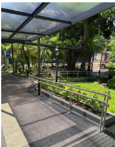
Rampas de acceso techado con pasamanos
